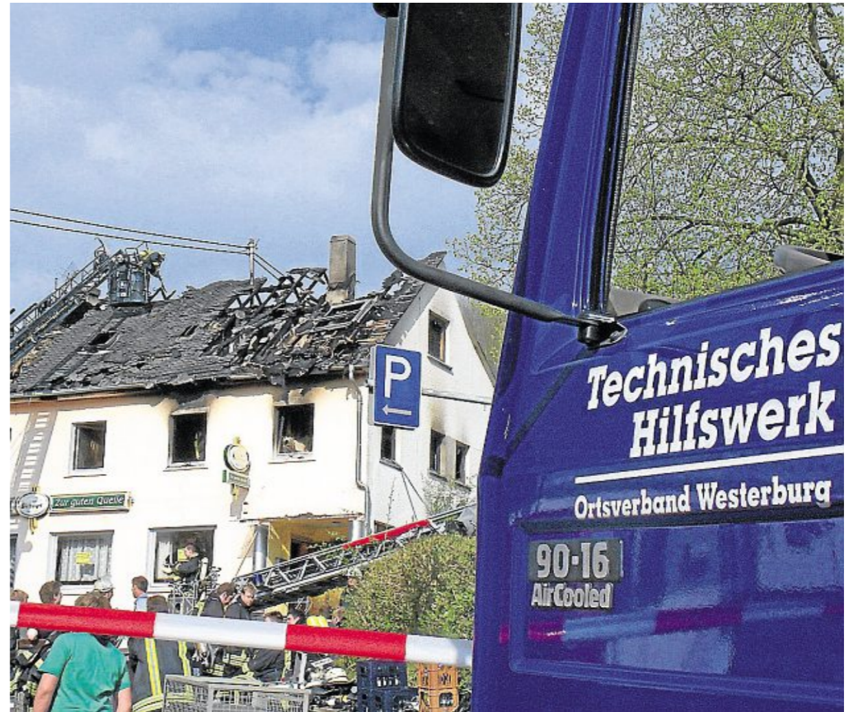
Unterstützung des THW bei einem Brand in Westerburg: Noch während der Löscharbeiten musste die Geschosdecke mit zusätzlichen Stützen verstärkt werden, um ein Zusammenbruch des Gebäudes zu verhindern.
