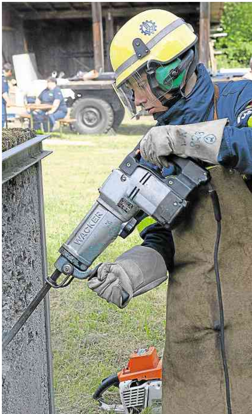
Vor dem Durchbruch: Indem Löcher in Wände gebohrt werden, kann festgestellt werden, ob sich hinter einer Wand ein Hohlraum befindet.
