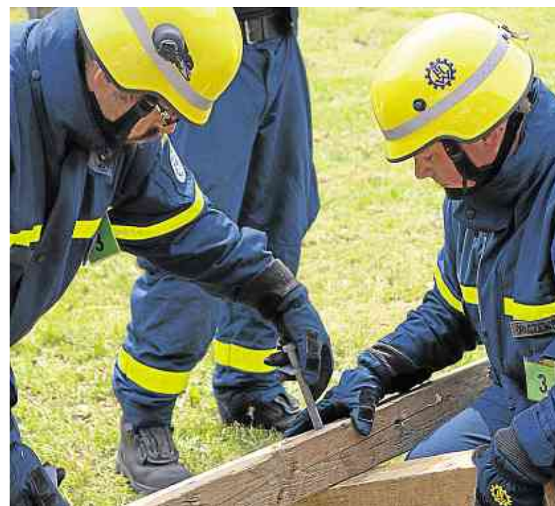
Zwei Kanthölzer werden verbunden. Sie können später etwa dazu dienen, die Statik von einsturzgefährdeten Gebäuden zu erhöhen.
