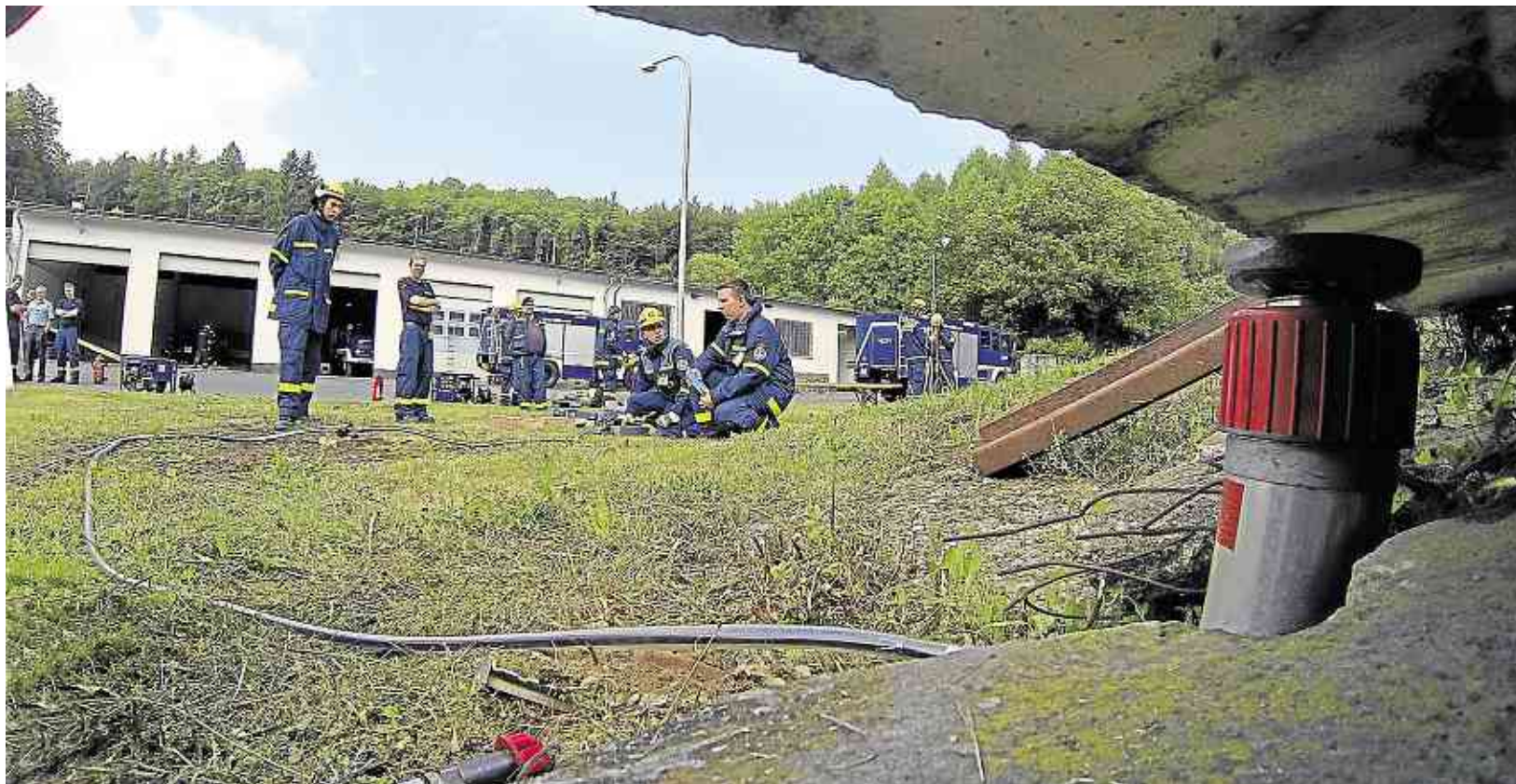
Hydraulikpumpen helfen den Rettern unter anderem dabei, verschüttete Personen aus eingestürzten Gebäuden zu bergen. Auf dem Bild wird eine schwere Betonplatte angehoben. Aus sicherer Entfernung beobachten die Helfer den Vorgang.
